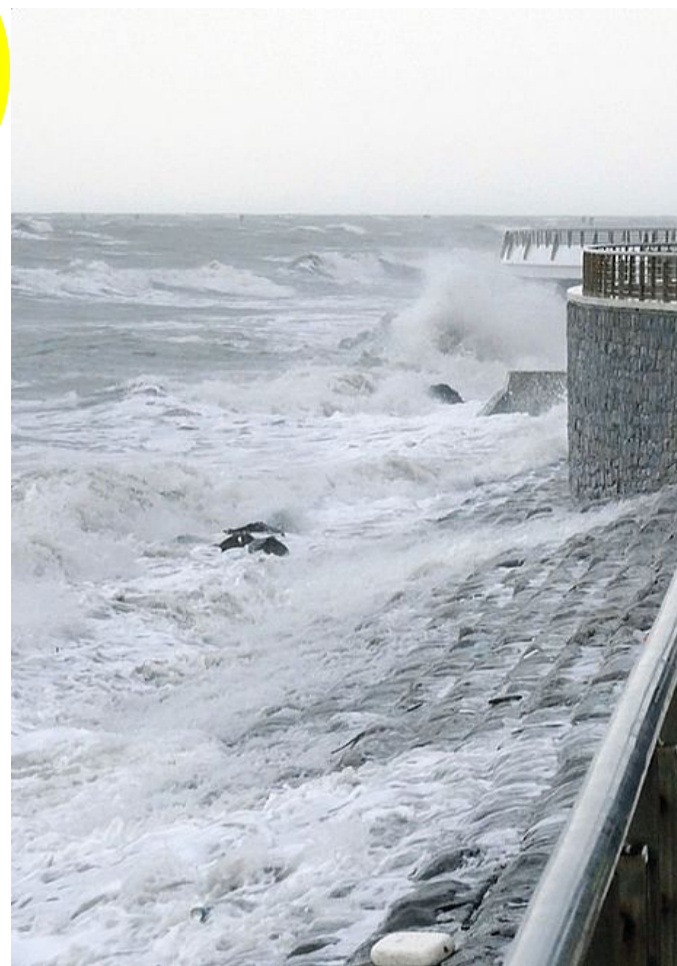
Le onde della sciroccata si infrangono sulla diga
